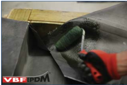
44. Inlijmen binnenzijde hoek.
