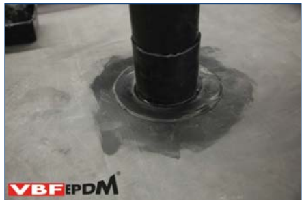
105. Het 1 e stuk zelfklevende Detailfolie geplaatst.
