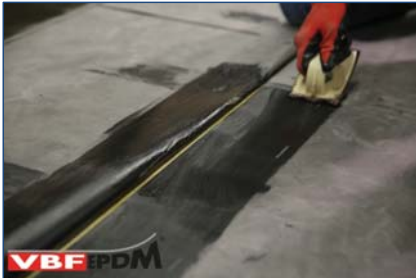
17. Aanbrengen Singleply Primer.
