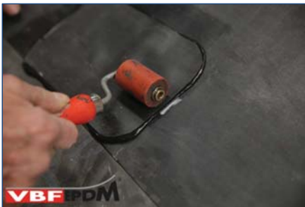
159. Reparatiestuk VBF-EPDM aanrollen.
