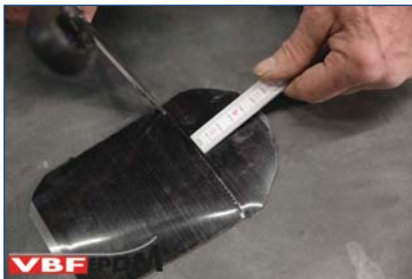
56. Op maat geknipt stuk zelfklevende Detailfolie, insnijden antikleefolie.
