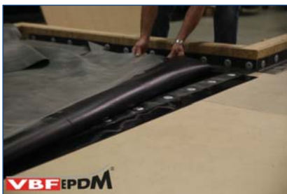
8. VBF-EPDM over GOB-stroken plaatsen.
