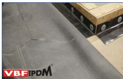
25. Bevestiging kimfixatiestrook.
