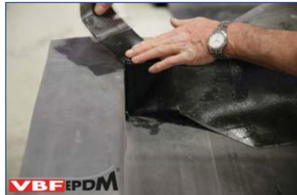
51. Aanbrengen zelfklevende naadtape op dakrand.
