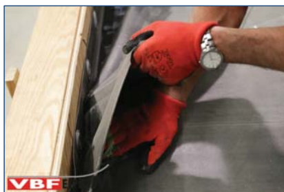
29. Aanbrengen VBF-EPDM op kimfixatiestrook.
