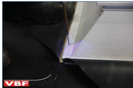
126. Lichtkoepelopstand mechanisch bevestigen.
