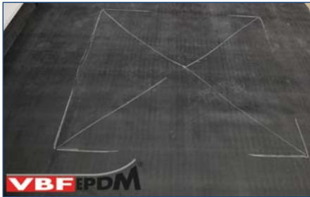
123. Aantekenen omtrek lichtkoepel opstand.
