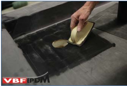
117. Aanbrengen Singleply Primer op VBF-EPDM.
