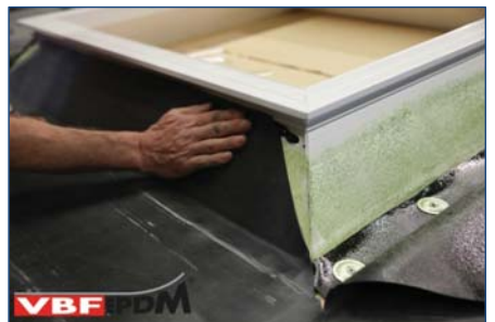
136. Aanwrijven VBF-EPDM met de vlakke hand.
