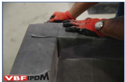
43. Wegvouwen overtollig materiaal.
