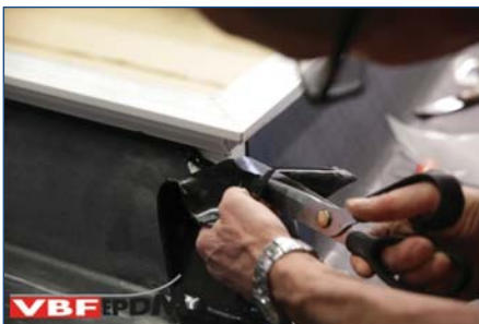
143. Zelfklevende EPDM bovenaan inknippen.
