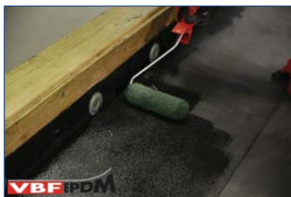
31. Aanbrengen KS-100 contactlijm.
