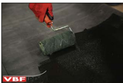
10. Aanbrengen contactlijm KS-100.
