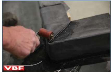
83. Hoekmanchet aanrollen met siliconenroller.
