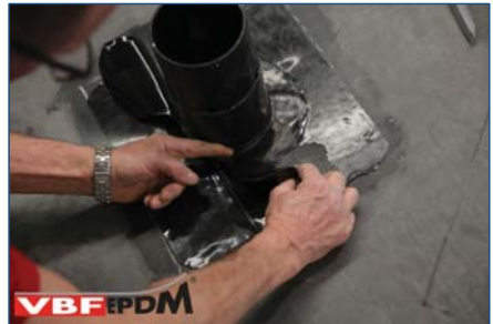
111. Positioneren 3 e stuk zelfklevende Detailfolie.
