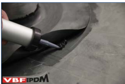
96. Afdichten met VB-9510 in het dakvlak.
