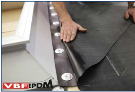
131. VBF-EPDM aandrukken met de vlakke hand.
