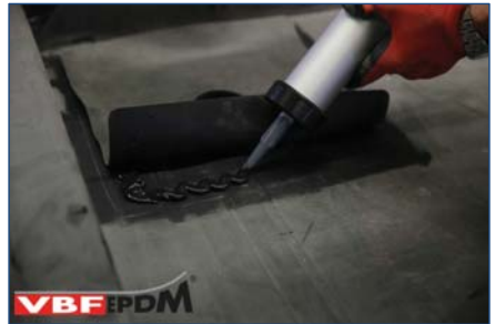
120. Afdichten slabbe met VB-9510.
