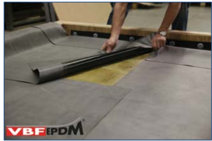
13. VBF-EPDM membraan in de droge lijm leggen.
