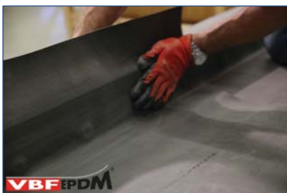
32. Aanwrijven VBF-EPDM tegen dakopstand.
