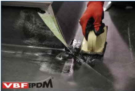
139. Aanbrengen Singleply Primer.
