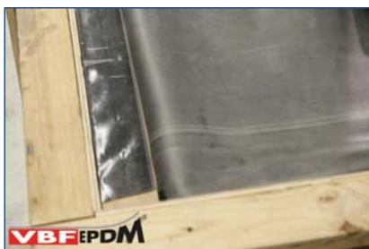
24. VBF-EPDM membraan teruggeslagen.
