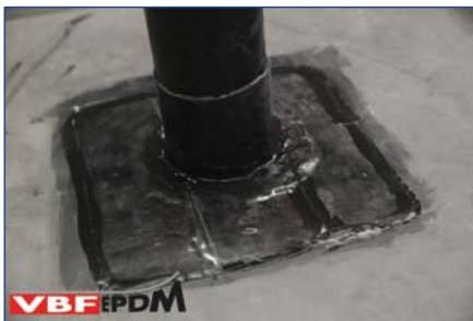
114. Ronde doorgaande doorbreking gereed.
