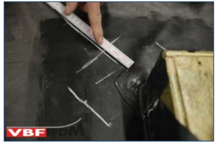
69. Opmeten 2 e stuk Detailfolie.
