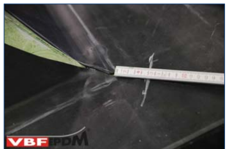
138. Opmeten 1 e deel zelfklevende EPDM tot 5 cm in het horizontale dakvlak.
