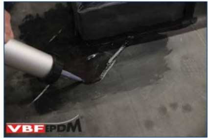
85. Zelfklevende Detailfolie afdichten met VB-9510.
