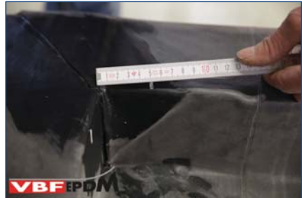
55. Opmeten Detailfolie minimaal 5x5x5 cm.
