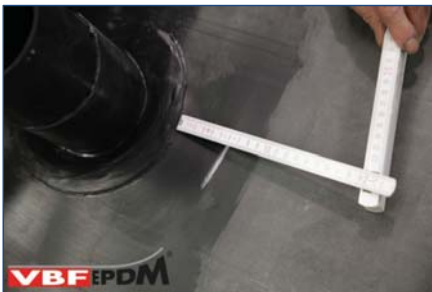
106. Opmeten 2 e stuk zelfklevende Detailfolie.
