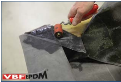
52. Aandrukken naadtape met siliconenroller.
