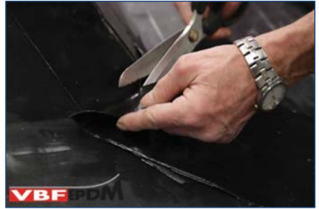
148. Overtollig materiaal afknippen en het gehele 2 e deel aanrollen met een siliconenroller.
