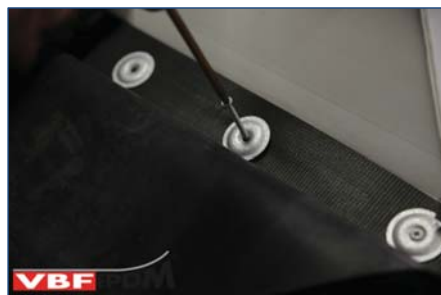
128. Mechanisch bevestigen kimfixatiestrook h.o.h. 15 cm.
