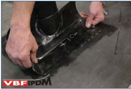
108. Positioneren 2 e stuk zelfklevende Detailfolie.
