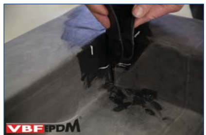
57. Aanzetten zelfklevende Detailfolie in het midden van de hoek.
