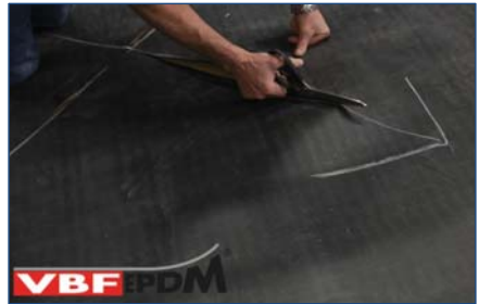
124. Kruislings inknippen VBF-EPDM membraan.
