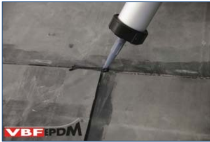
23. Afwerken naadverbinding bij T-naad.
