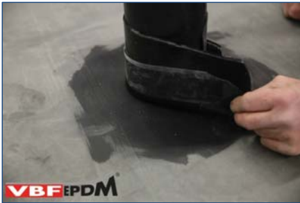
102. Positioneren 1 e deel zelfklevende Detailfolie.
