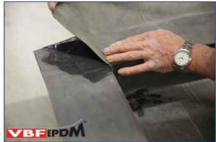
53. Dichtvouwen VBF-EPDM op dakrand.
