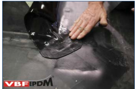
142. Afgeronde deel aandrukken met vlakke hand.
