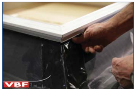
144. Zelfklevende EPDM onder koepelrand aandrukken.
