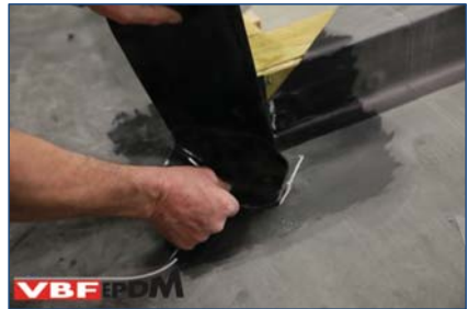
71. Positioneren 2 e stuk zelfklevende Detailfolie.
