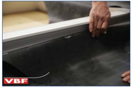
132. Aantekenen opstandhoogte.
