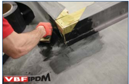
63. Aanbrengen Singleply Primer.
