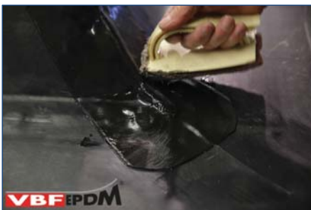
145. Grondvlak voorzien van Singleply Primer.
