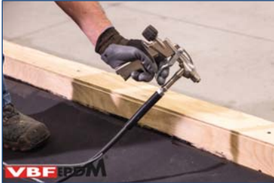
34. Aanbrengen spuitlijm.
