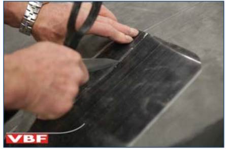
101. Antikleefolie voorzichtig doorsnijden.
