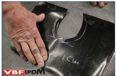
107. Op maat knippen 2 e stuk zelfklevende Detailfolie
