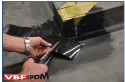
73. In het midden inknippen 2 e stuk Detailfolie.
