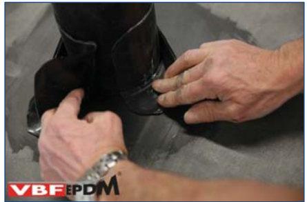
103. Detailfolie aandrukken in grondvlak.
