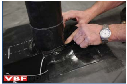
109. Positioneren 2 e stuk zelfklevende Detailfolie.
