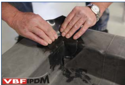
58. Aanbrengen zelfklevende Detailfolie.
