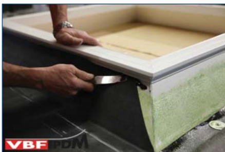
137. Dichtdrukken VBF-EPDM met kitlepel.
