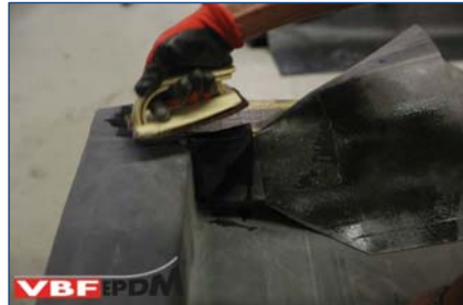
49. Aanbrengen Singleply Primer op dakrand.
