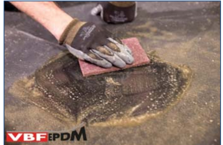
152. Reinigen reparatieplek.
