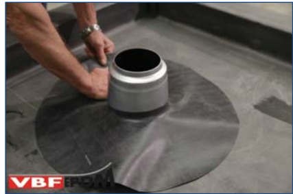
89. Plaatsen manchet op membraan en omtrek aantekenen.
