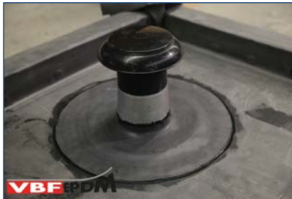
99. Ronde dakdoorvoer gereed.
