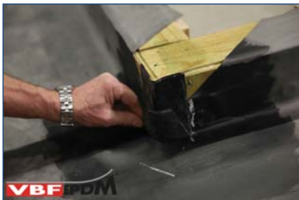
66. Aanbrengen zelfklevende Detailfolie.
