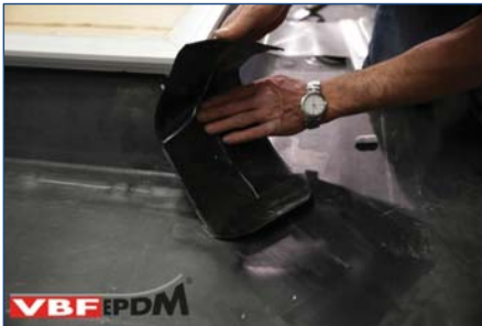
141. Positioneren 1 e deel zelfklevende EPDM.
