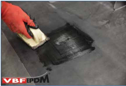
155. Ondergrond voorzien van Singleply Primer.
