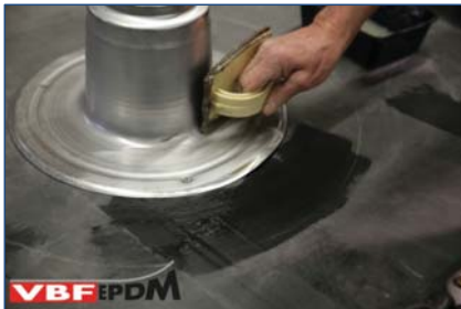
90. Ondergrond voorzien van Singleply Primer.
