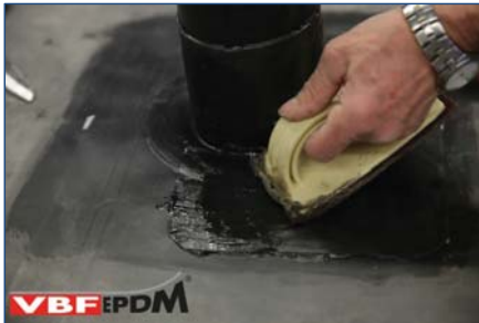
110. Overlapzone voorzien van Singleply Primer.
