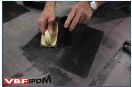
118. Slabbe VBF-drain voorzien van Singleply Primer.
