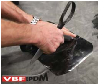
70. Insnijden zelfklevende antikleefolie met schaar.
