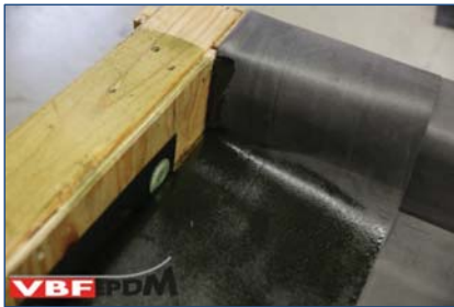
36. Ingelijmde dakopstand t.p.v. binnenhoek.
