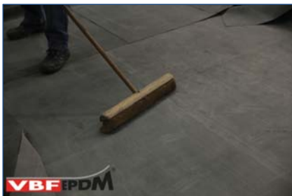
14. Aanvegen membraan met zachte bezem.
