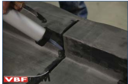
22. Afwerken naadverbinding bij overgang van horizontaal naar verticaal vlak.
