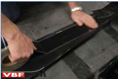
19. Aanbrengen zelfklevende naadverbindingstape.
