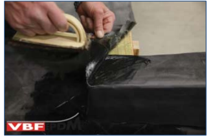
81. Aanbrengen Singleply Primer in hoekmanchet.
