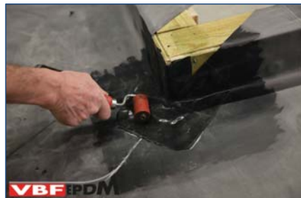
75. Aanrollen Detailfolie met siliconenroller.
