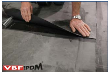
20. Sluiten naadverbinding en verwijderen antikleef folie.
