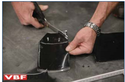
65. Op maat knippen zelfklevende Detailfolie.
