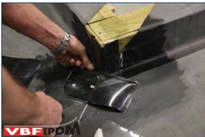
74. Aanbrengen Detailfolie tegen opgaande dakrand.
