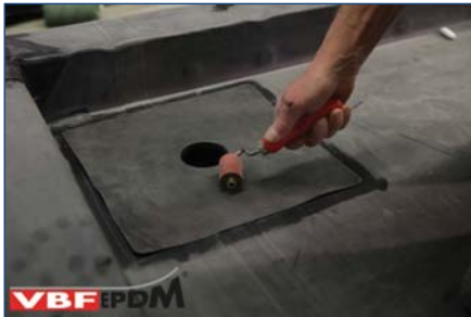
119. Aanrollen slabbe VBF-drain.
