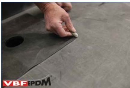
115. Aantekenen positie VBF-drain.
