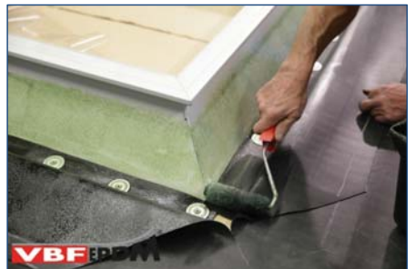
134. Inlijmen lichtkoepelopstand en VBF-EPDM.
