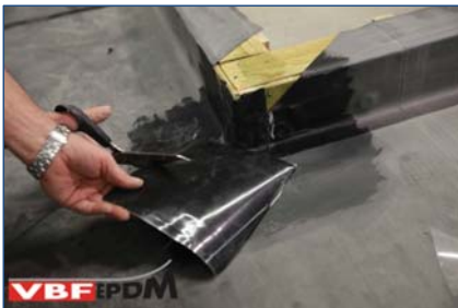
72. Op maat knippen 2 e stuk zelfklevende Detailfolie.
