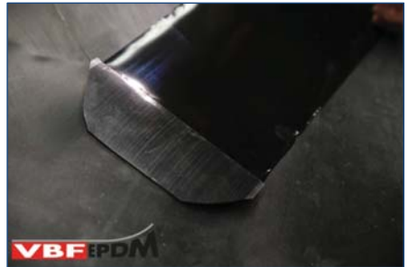
140. Antikleefolie deels verwijderen.
