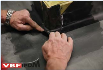
68. Aanbrengen zelfklevende Detailfolie in dakvlak.
