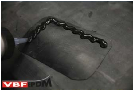
157. Reparatiestuk VBF-EPDM voorzien van VB-9510.
