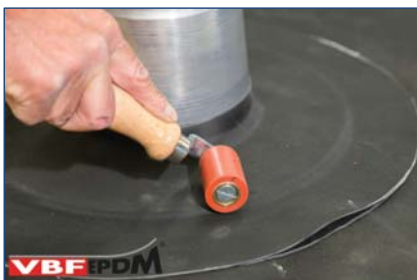
94. Aanrollen geprimerd deel.
