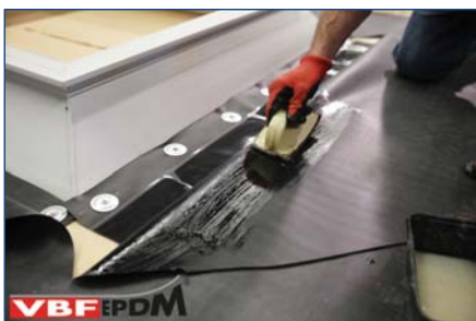
129. Aanbrengen Singleply Primer.
