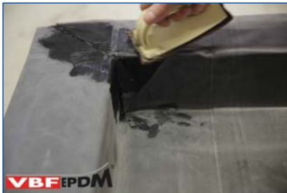
54. Aanbrengen Singleply Primer op dakrand.
