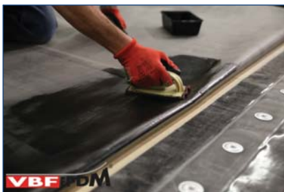
6. Singleply Primer aanbrengen.
