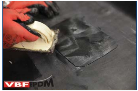
156. Reparatiestuk voorzien van Singleply Primer.
