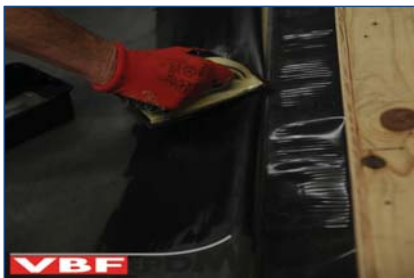
26. Aanbrengen Singleply Primer.
