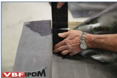
50. Aanbrengen zelfklevende naadtape in binnenhoek.
