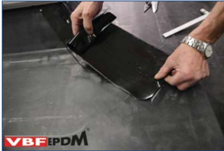
147. Positioneren 2 e deel zelfklevende EPDM.
