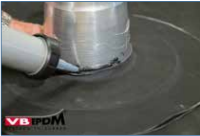
Bild 94. Randabdichtung des Formteils.
