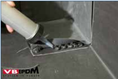
Bild 61. Formteilabdichtung mit VB-9510.
