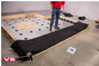
Bild 2. Ausrollen der VB-EPDM Membrane.
