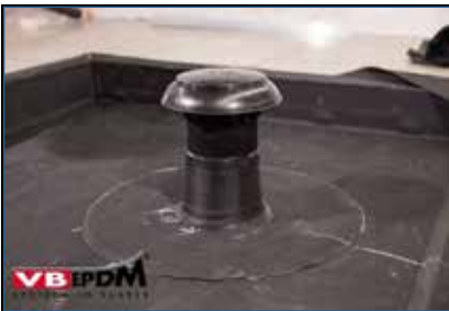
Bild 102. Fertig abgedichtete Durchdringung.
