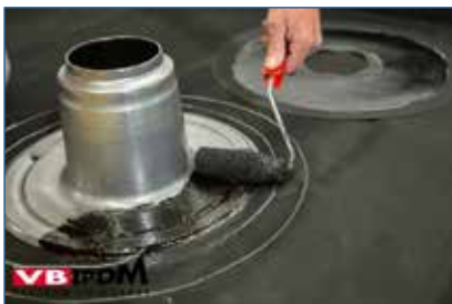
Bild 90. KS-100 Bodenverklebung.
