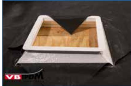
114. Zurückfalten der EPDM Membranseiten.
