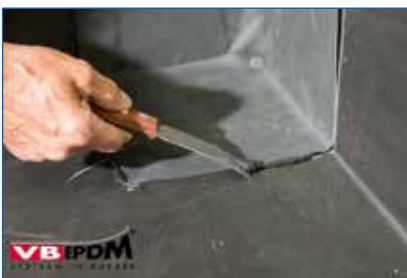
Bild 63. Entfernen der VB-9510 Reste.
