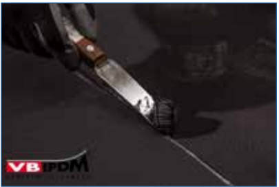
Bild 26. Entfernen der VB-9510 Reste.
