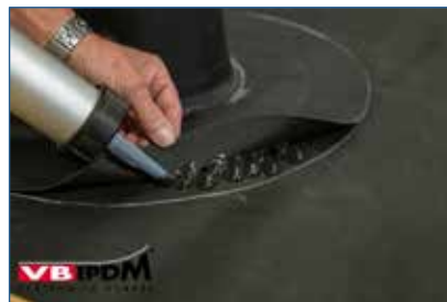
Bild 99. Abdichten der Überlappung.
