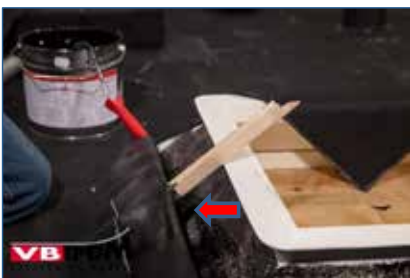
119. Trennung der verklebten Teile.
