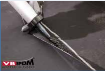
Bild 24. VB-9510 Abdichtungsmasse aufbringen.
