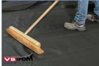
Bild 19. Anfeigen VB-EPDM Folie mit Besen.
