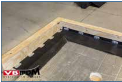
Bild 36. Armierter Attikabefestigungsstreifen.
