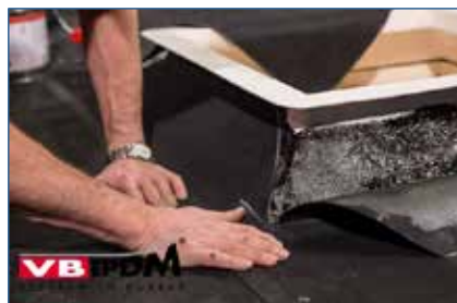
120. Andrücken der verklebten Flächen.
