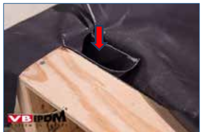
Bild 44. Materialüberschuss bildet eine „Tasche“.
