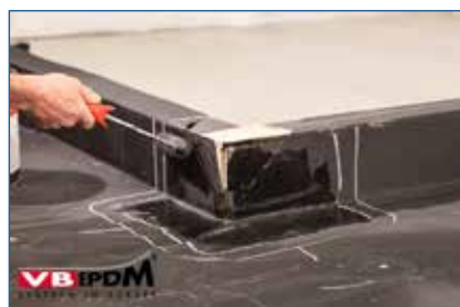
Bild 72. KS-100 Membranverklebung.
