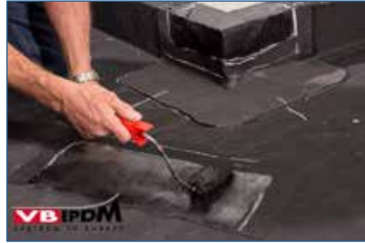
Bild 81. KS-100 Streifenverklebung.
