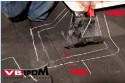
123. KS-100 Verklebung der EPDM Membrane.
