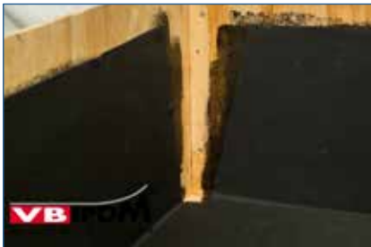
Bild 53. Eingeschnittener Inneneckbereich.
