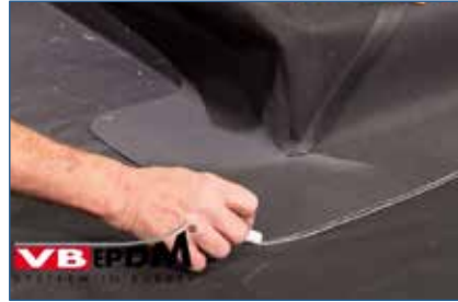
122. Formteil auf die Membrane anzeichnen.
