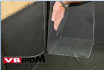
Bild 59. Formteil mit der flachen Hand andrücken.
