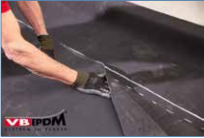
Bild 22. Überlappung schliessen.
