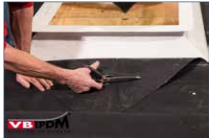
116. Abschneiden der EPDM Membranseiten.
