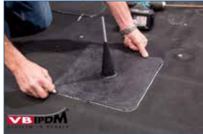
Bild 104. Formteil anzeichnen.
