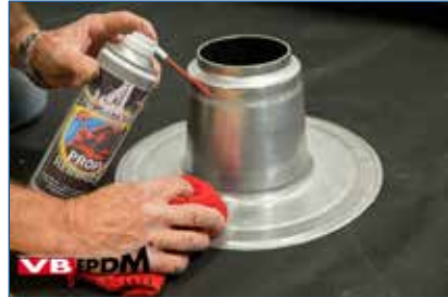
Bild 85. Oberfläche entfetten.
