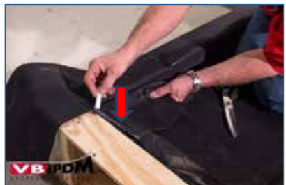
Bild 42. Dachrand auf die EPDM-Folie anzeichnen.
