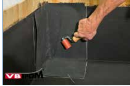
Bild 60. Formteil mit silikonroller andrücken.
