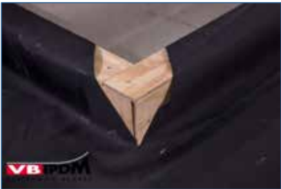
Bild 67. Membrane um die Ecke gefaltet.
