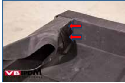
Bild 46. Verklebte Taschenvorderseite.
