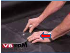
Bild 6. Schraublochmarkierung.
