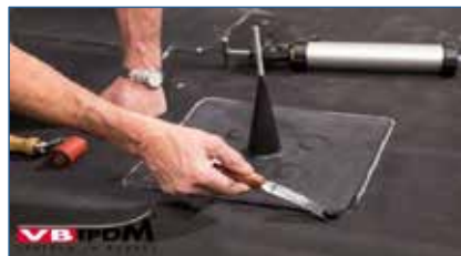
Bild 110. Entfernen der VB-9510 Reste.
