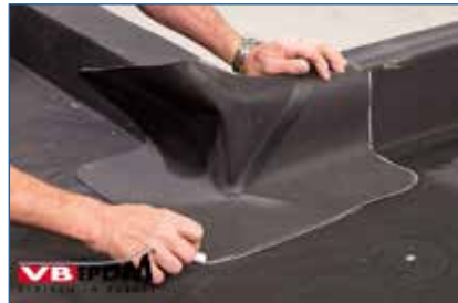
Bild 68. Formteil plazieren und anzeichnen.
