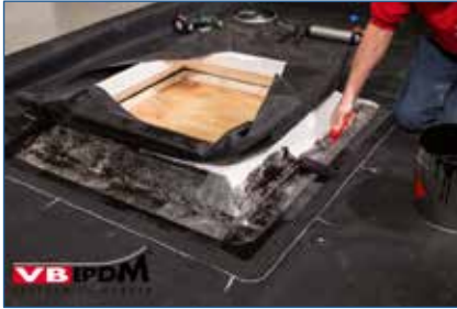
132. KS-100 Verklebung der Aufstände.
