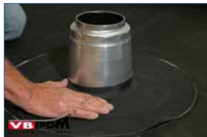
Bild 91. Montage des Formteils.
