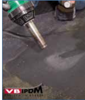
150. Heißluftgerät verwenden.
