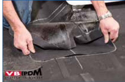
124. Montage des verklebten Formteils.
