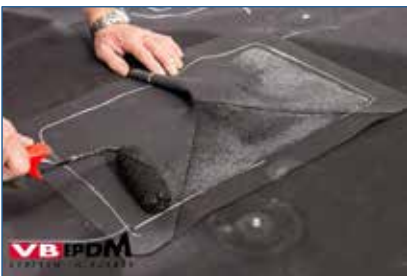
Bild 71. KS-100 Formteilverklebung.
