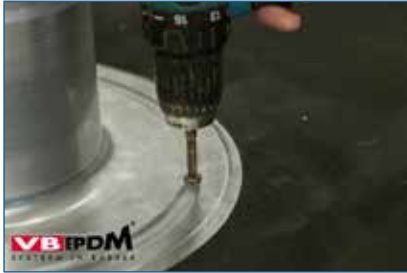
Bild 84. Mechanische Befestigung der Durchdringung.
