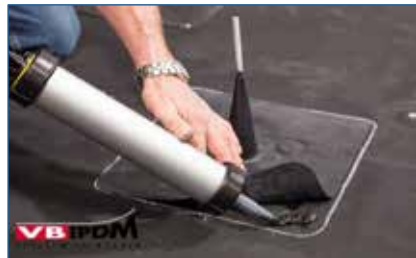
Bild 108. Abdichten der Überlappung.
