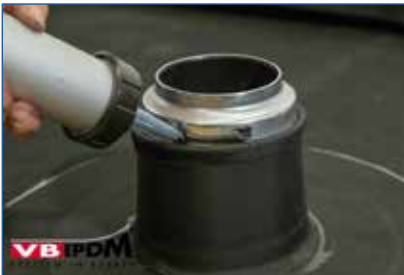
Bild 98. Randabdichtung des Formteils.
