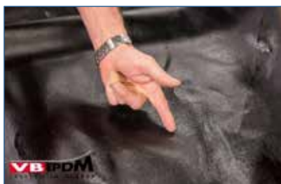
Bild 30. Abgelüfteter KS-100 Kleber.
