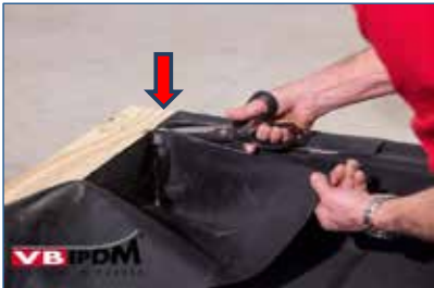
Bild 39. Einschnidung bis 1 cm vor die Ecke.
