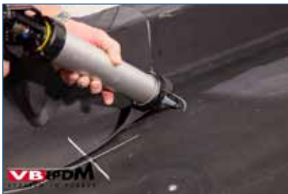
Bild 77. Abdichten der Überlappung.
