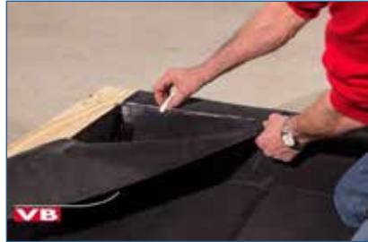
Bild 38. Dachrand anzeichnen auf die EPDM Folie.
