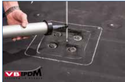
Bild 106. VB-9510 Abdichtungsmasse aufbringen.
