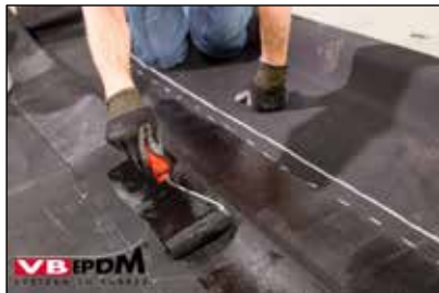
Bild 21. Auftragen des KS-100 Kontaktklebers.
