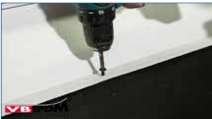
130. Mechanische Befestigung der Lichtkuppel.
