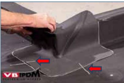
Bild 69. Formteil plazieren und anzeichnen.
