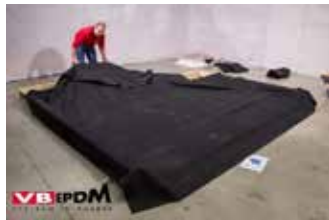
Bild 3. Ausfalten der VB-EPDM Membrane.
