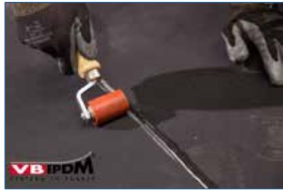
Bild 25. Überlappung im VB-9510 Bereich anrollen.
