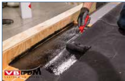
Bild 29. Attikabefestigung durch KS-100 Verklebung.
