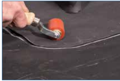
Bild 23. Überlappung im Kleber Bereich anrollen.
