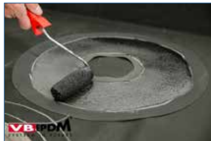
Bild 89. KS-100 Formteilverklebung.
