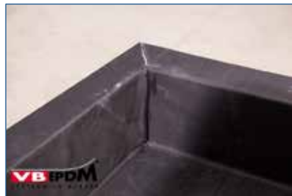
Bild 52. Fertige Innenecke.
