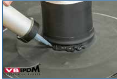
Bild 97. Abdichtung zwischen den beiden Formteilen.
