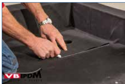
140. Position des Wasserablaufs anzeichnen.
