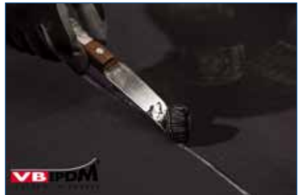
156. Entfernen der VB-9510 Reste.
