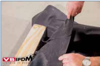
Bild 41. EPDM-Folie in die Ecke falten.
