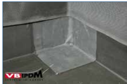
Bild 64. Fertige Innenecke.
