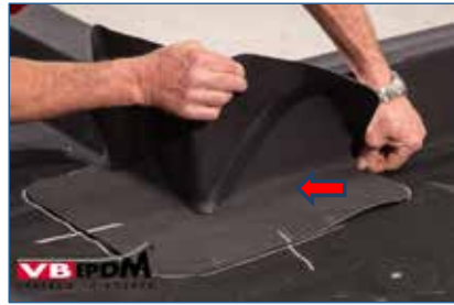
Bild 74. Formteil plazieren. Hohlräume vermeiden.
