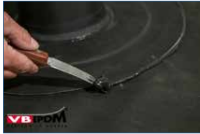
Bild 101. Entfernen der VB-9510 Reste.
