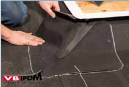
125. Montage des verklebten Formteils.
