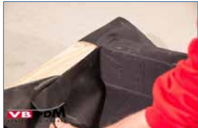
Bild 40. EPDM Folie in die Ecke falten.
