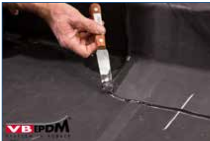
Bild 79. Entfernen der VB-9510 Reste.
