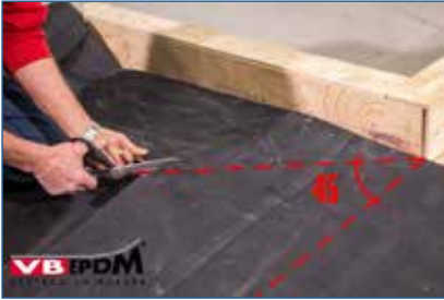
Bild 65. EPDM Membrane unter 45° einschneiden.
