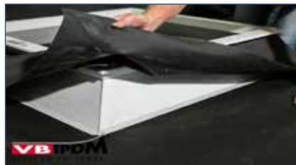
131. Ausrichten des Formteils.
