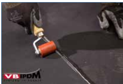
25. Aanrollen lijm-kit naad met siliconenroller.
