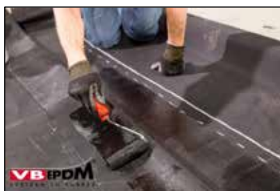
21. Aanbrengen KS-100 contactlijm.
