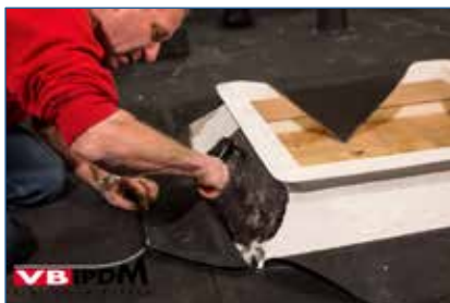
118. Inlijmen lichtkoepelopstand met lijmvrije zone.
