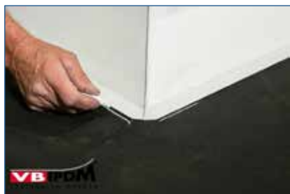
111. Aantekenen doorbreking.
