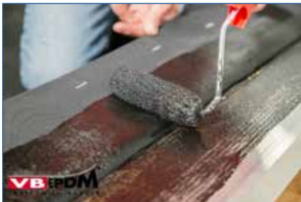
149. Inlijmen daktrim + membraan.
