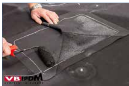
71. Inlijmen prefab buitenhoek.
