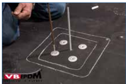
105. Mechanisch bevestigen membraan.
