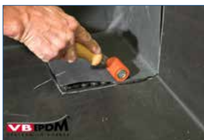
62. Het gekitte deel aanrollen met siliconenroller.
