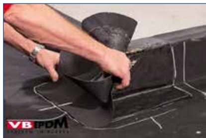
73. Aanbrengen prefab hoekstuk.
