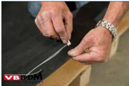
152. Aantekenen af te knippen deel.
