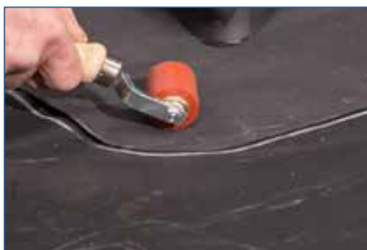
23. Aanrollen lijmnaad met siliconenroller.
