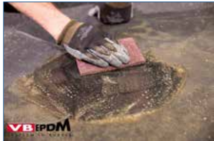
159. Reinigen reparatieplek.
