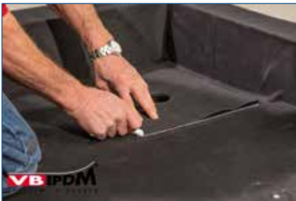
140. Aantekenen positie VB-drain.
