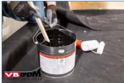
28. Roeren contactlijm KS-100.
