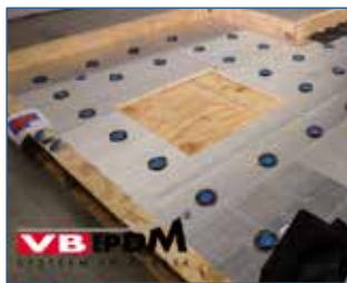
5. Thermofix® elementen bevestigd.
