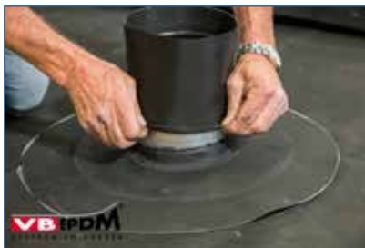
95. Aanbrengen prefab sokmanchet.
