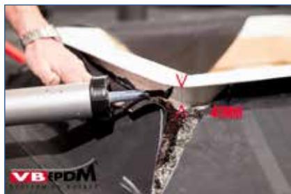
121. Bovenzijde membraan afdichten met VB-9510.
