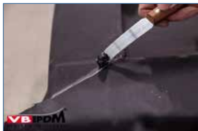
51. Overtollige VB-9510 verwijderen.
