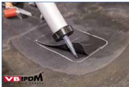
165. Afdichten reparatiestuk met VB-9510.
