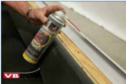
147. Ontvetten aluminium daktrim.
