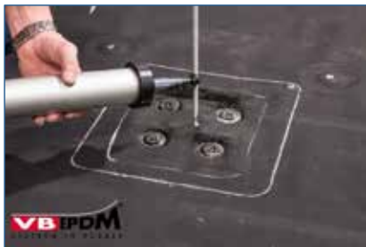
106. Aanbrengen VB-9510 op doorbreking.
