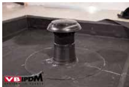
102. Ronde dakdoorvoer gereed.
