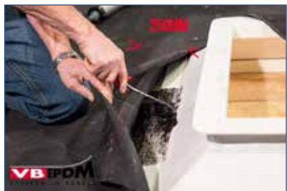
117. Inlijmen lichtkoepelopstand.
