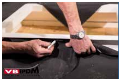
115. Aantekenen opstandhoogte.
