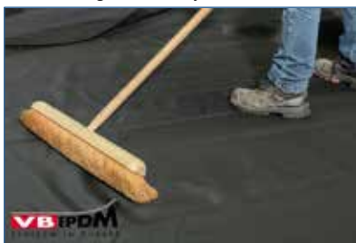
19. Aanvegen membraan met zachte bezem.
