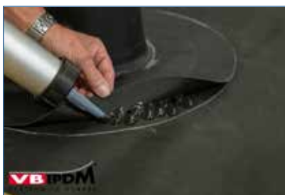
99. Afdichten met VB-9510 in het dakvlak.
