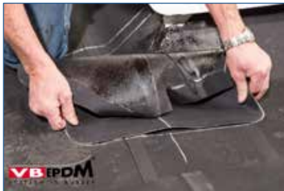
124. Plaatsen prefab hoekstuk.
