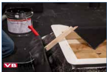
119. Gescheiden drogen van lijm.
