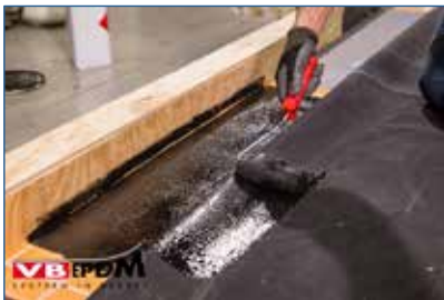
29. Aanbrengen contactlijm KS-100.
