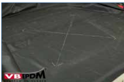
112. Inknippen membraan ( Let op valbeveiliging! ).
