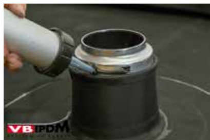
98. Afdichten met VB-9510 langs bovenzijde.
