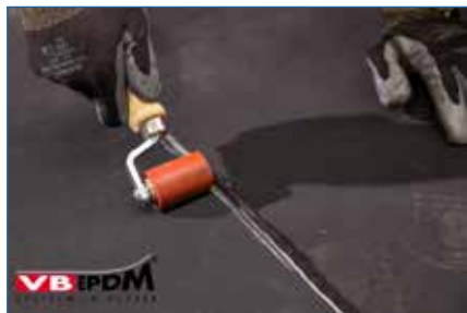
166. Aanrollen reparatiestuk met siliconenroller.
