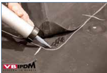
137. Onderzijde manchet afdichten met VB-9510.
