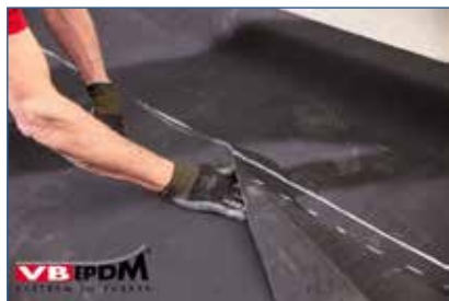
22. Dichtvouwen VB-EPDM naadverbinding.
