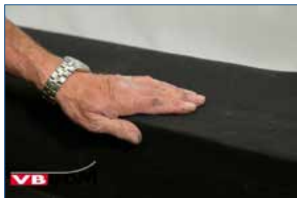
151. Ploovrij aanvegen lijmdeel met vlakke hand.
