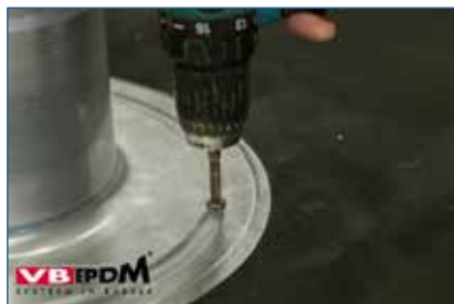
84. Plakplaat mechanisch bevestigen.
