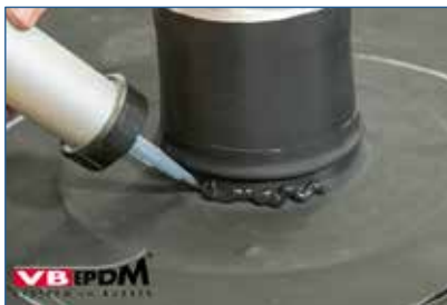
97. Afdichten met VB-9510 langs onderzijde.
